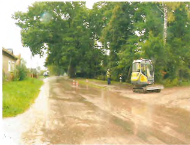
Zdjęcie 2 : Przebudowa chodnika w miejscowości Łukta, ul. Mazurska.
