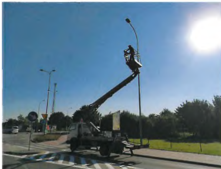
Zdjęcie 3: Modernizacja oświetlenia na terenie Gminy Łukta.
