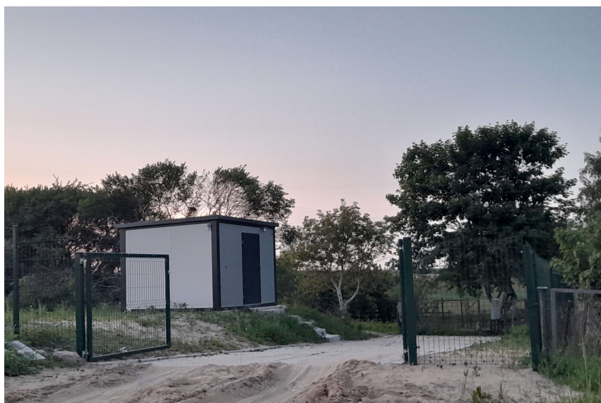
Zdjęcie 2 : Stacja podwyższania ciśnienia w miejscowości Ramoty
