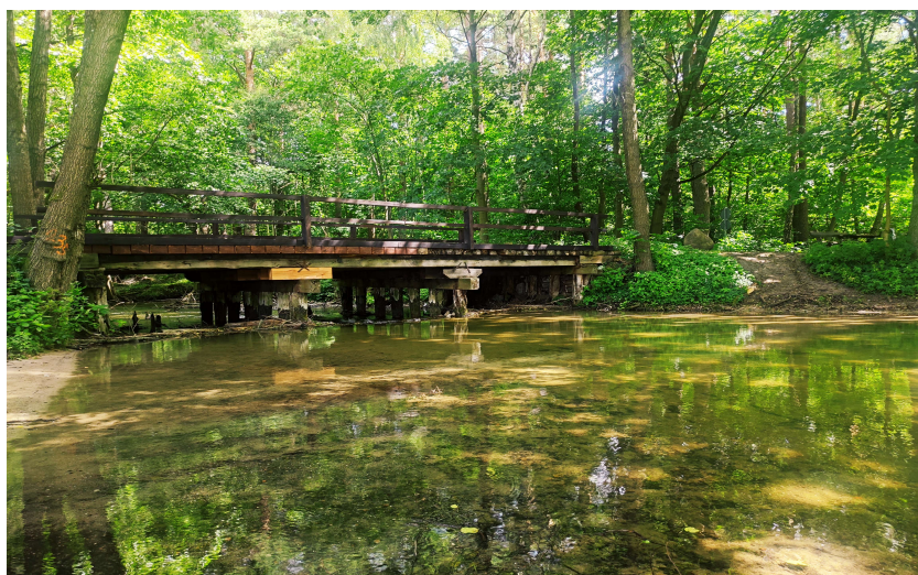
Zdjęcie 3: Przebudowany most na rzece Pasłęce w miejscowości Pelnik
