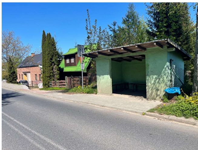
Zdjęcie 5: Nowy chodnik w miejscowości Worliny.
