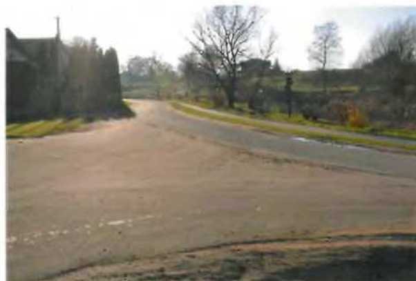
Zdjęcie 1 : Nowo przebudowana droga Ględy – Trokajny.
