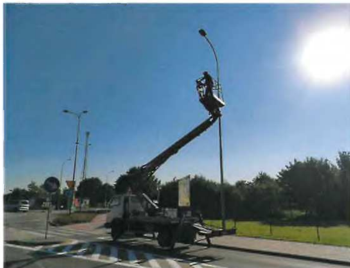
Zdjęcie 3: Modernizacja oświetlenia na terenie Gminy Łukta.
